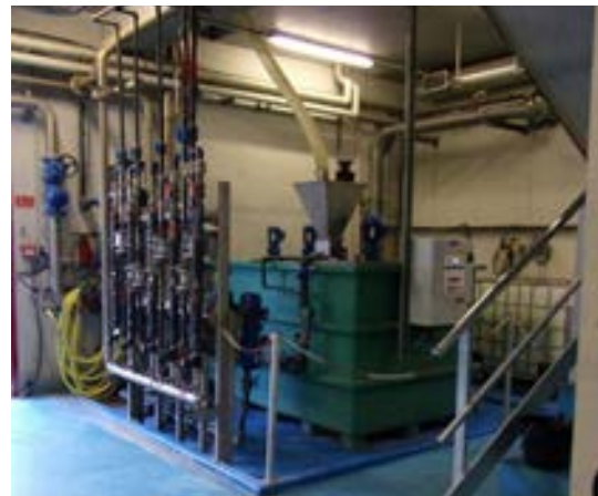
Unité de préparation et d'injection de polymère (STEP Bourg-en-Bresse - CAG3B) Source : GEDEAU CONSEIL
